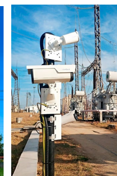
Системы технологического видеонаблюдения и контроля технического состояния оборудования ПС
