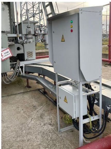
Собственная разработка «Анализатор растворенных газов Лазер» на базе лазерной технологии
