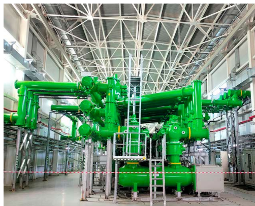
Инжиниринг и интеграция АСМД силовых трансформаторов и КРУЭ по протоколу МЭК 61850.
