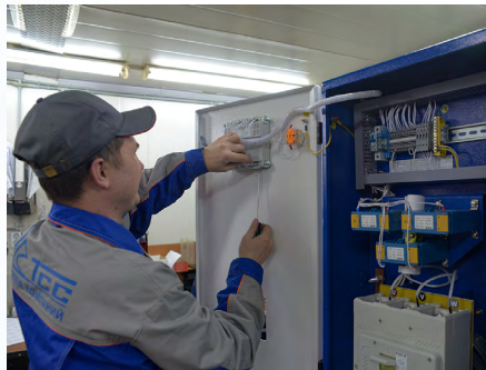
СБОРКА ЩИТОВ УПРАВЛЕНИЯ
