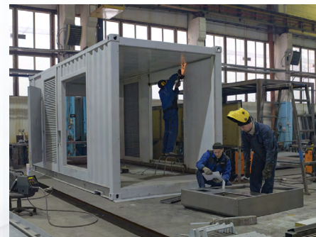
ЦЕХ ИЗГОТОВЛЕНИЯ КОНТЕЙНЕРОВ
