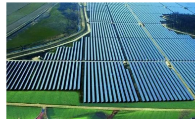
Старомарьевская СЭС 100 МВт
