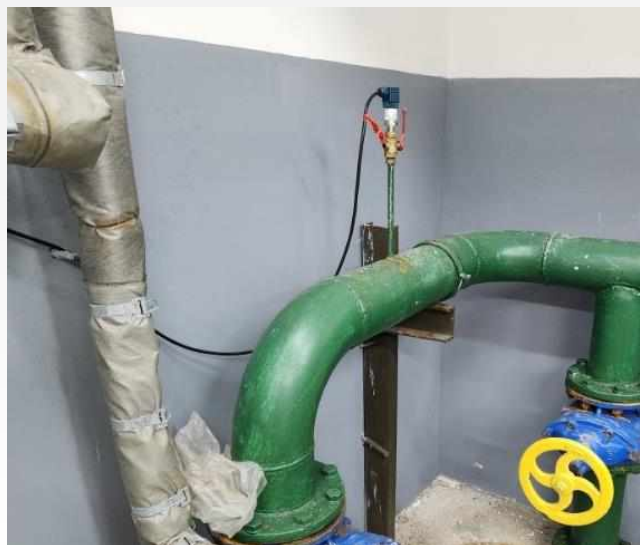
Процесс подключения преобразователя давления насосной станции
