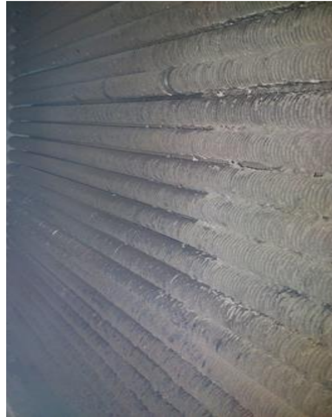
Рис. 1. Изображение загрязненного промышленного теплообменного аппарата, установленного на промышленном объекте Республики Татарстан, г. Казань
