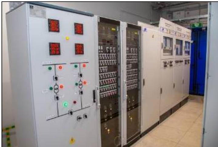
Блок ЭС и САУ разделен на отсек САУ и отсек электроснабжения.
