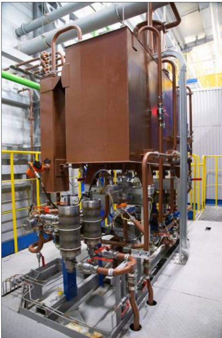
Системы маслообеспечения ГТД и маслообеспечения генератора и редуктора отдельные.
