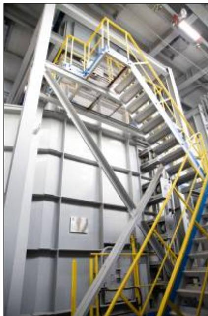
Котел-утилизатор водогрейный горизонтального типа состоит из бти теплообменных секций с вертикальным расположением труб. Каждая трубная секция включает в себя два блока по ширине газохода, в каждый блок включены 102 оребренные трубы  $\text{Ø } 38 \times 3$ , сталь 20.
