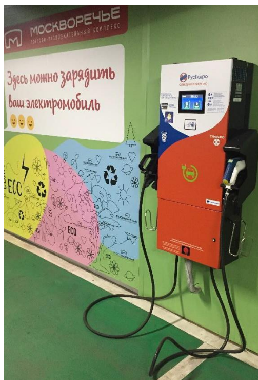
вид ЭЗС: DC wallbox, 24 кВт марка: Schneider Electric объект: ТРЦ Москворечье, г. Москва
