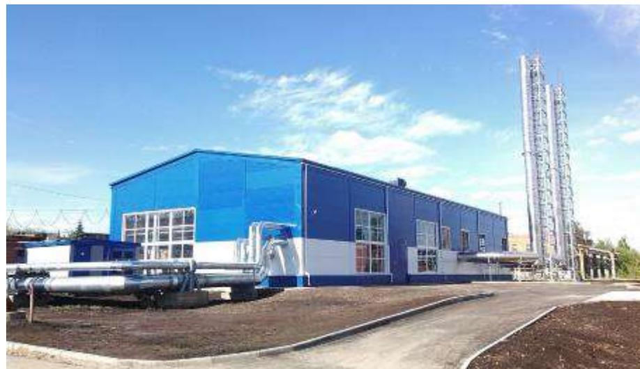
Индивидуальный источник теплоснабжения и переход с пара на теплофикационную воду в технологическом процессе, а также снижение потерь в тепловых сетях позволили снизить потребление тепловой энергии на 30%.
