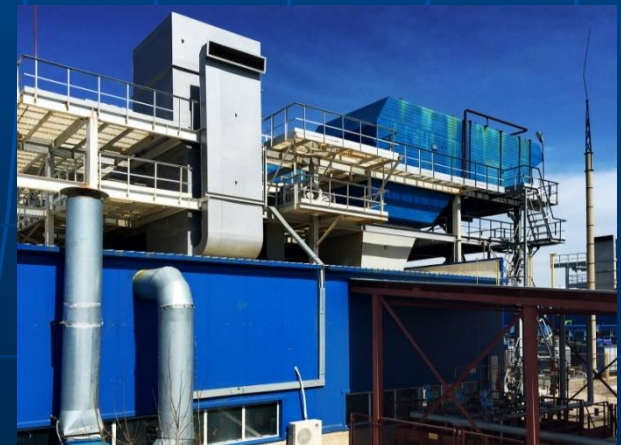
Общий вид установленной АБХМ фирмы "Thermax"
