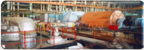
Паровая турбина Р-50-130/13 (производства «ЛМЗ» ) - 1 шт. ст.№7
