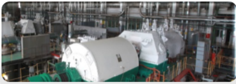
Паровая турбина ПТ-60-130/12/1,2 (производства «ЛМЗ» ) - 2шт. ст.№№5,6
