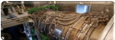
Газовые турбины ГТЭ-20/НК-37 (производства ПАО «Кузнецов») - 2шт. ст.№№1,2
