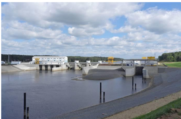
Витебская ГЭС 40 МВт
