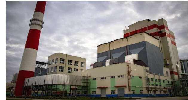
ОАО «Светлогорский ЦКК», мини-ТЭЦ 70 МВт на древесных отходах (отходы производства)
