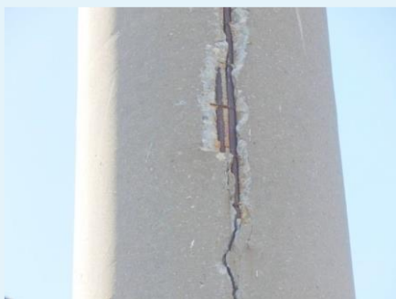
Рис. 8 – примеры дефектов опор:
