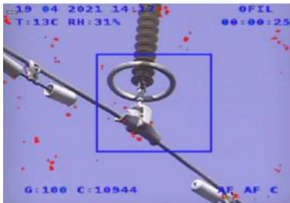
Рис. 6 – Пример обнаружения дефекта УФ обследованием
