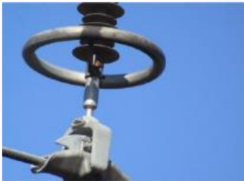
Рис. 7 – Пример проведения визуального осмотра
