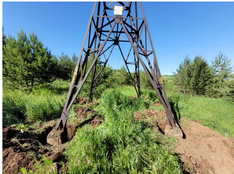
Разрушение фундаментов опор, 1960г.
