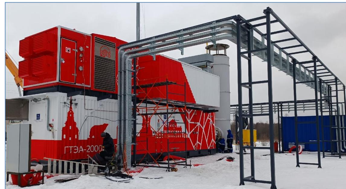
**Сборка энергоблока: в составе с ТГ и ГТД АА-2000**
